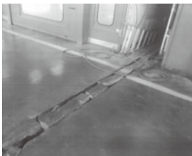
震災発生当時のひび割れの様子
