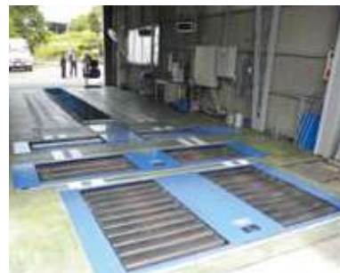
検査ラインには埋め込みピットも併設
