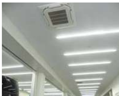
エアコン完備の屋内整備ストール
