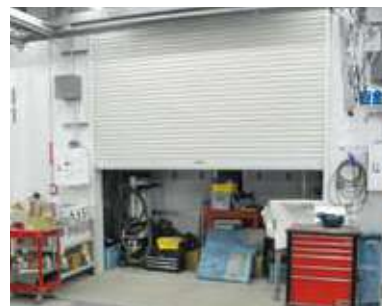
防塵のため機器収納のシャッターを完備
