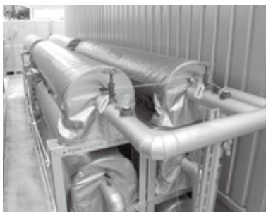
水道配管の途中にあるため常に新鮮な貯蔵水
