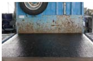
ウッドプロテクト 施工写真
