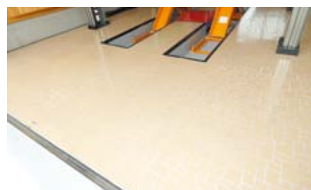
タイル調の床面塗装および壁面の木目調パネルの貼り付けは社長が施工
